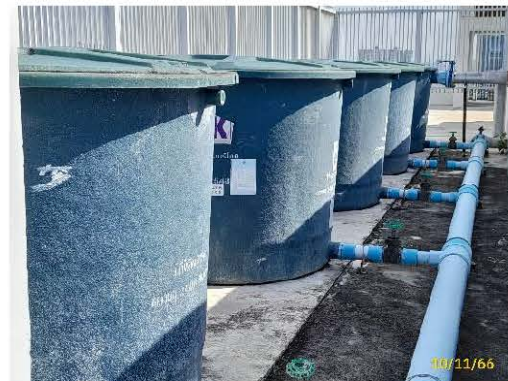
ถังเก็บน้ำสำรอง (ดาดฟ้า อาคาร B)
